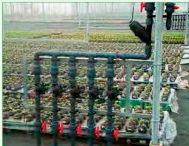
Applicazione di 2 o più elettrovalvole di alimentazione per una barra Installation of 2 or more solenoid valves to supply the boom Aplicación de 2 o más electroválvulas de alimentación para una barra
